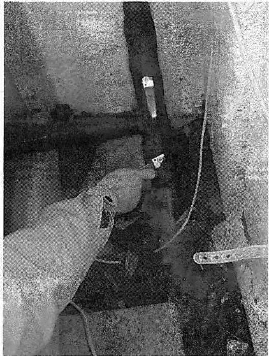
※水抜き作業は水洗金具の水抜き栓を取り外し、水抜きバルブを開ける等を行います
